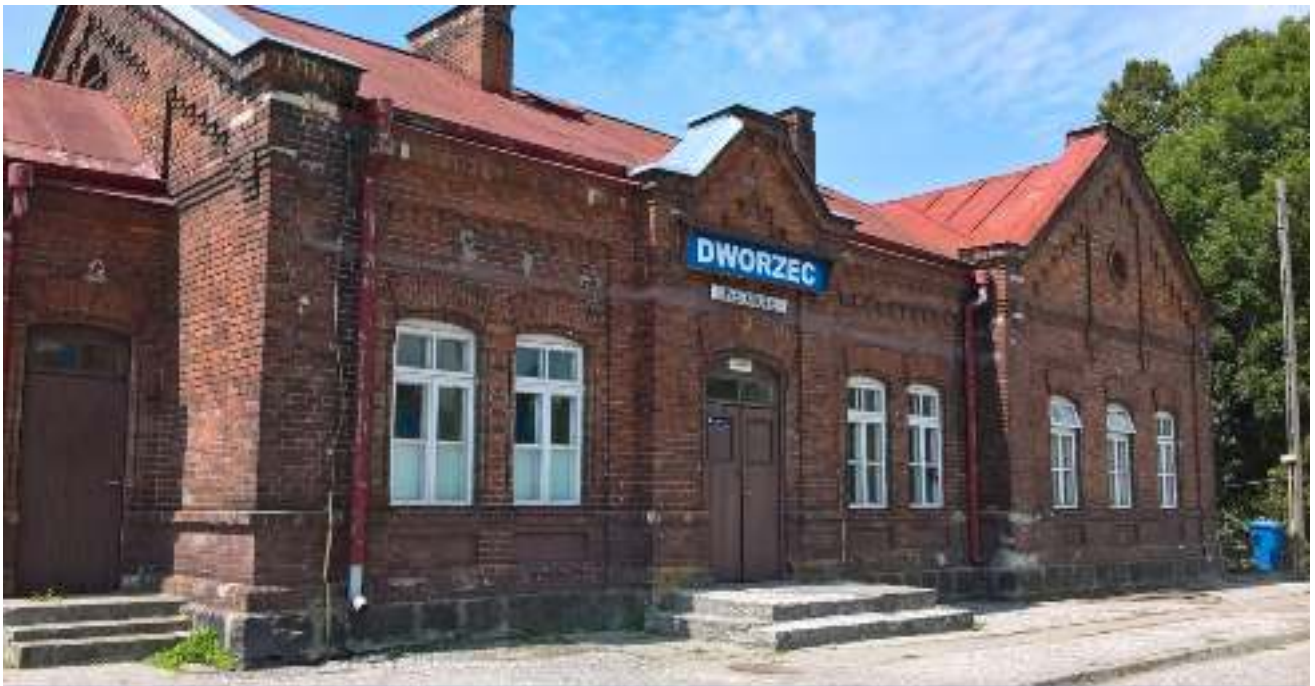
Fot.7. Dworzec kolejowy w Jaszczywie (fot. D. Zdunek)
