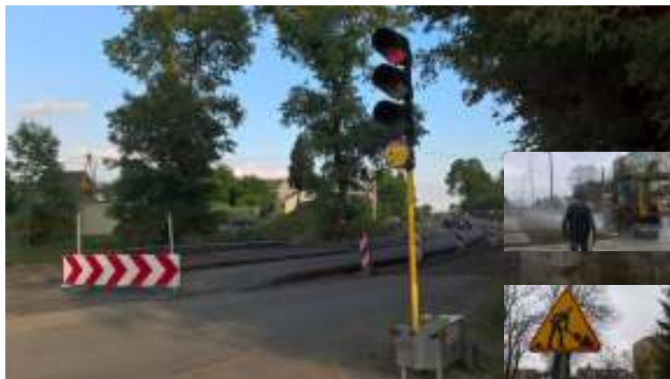
Fot.6. Remont drogi wojewódzkiej nr 829 (fot. D. Zdunek)
