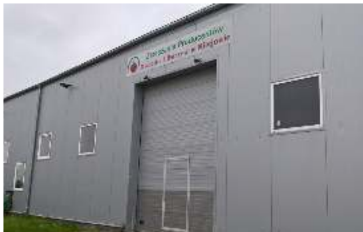
Fot. 17. Budynek Zrzeszenia Producentów Owoców i Warzyw w Milejowie (fot. D. Zdunek)
