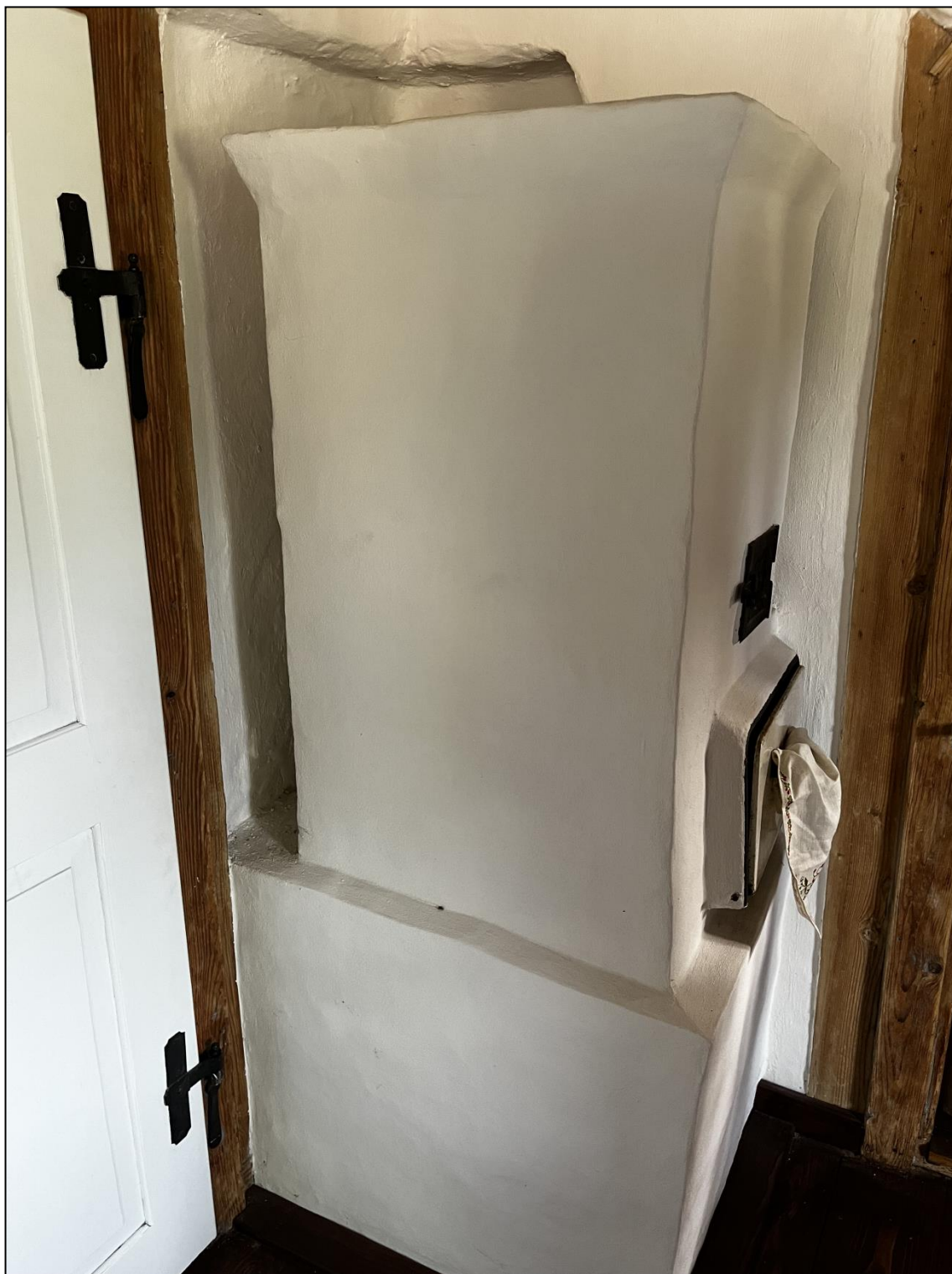
Fotografia 27. Zachowany oryginalny piec w budynku starej szkoły w Starej Wsi
